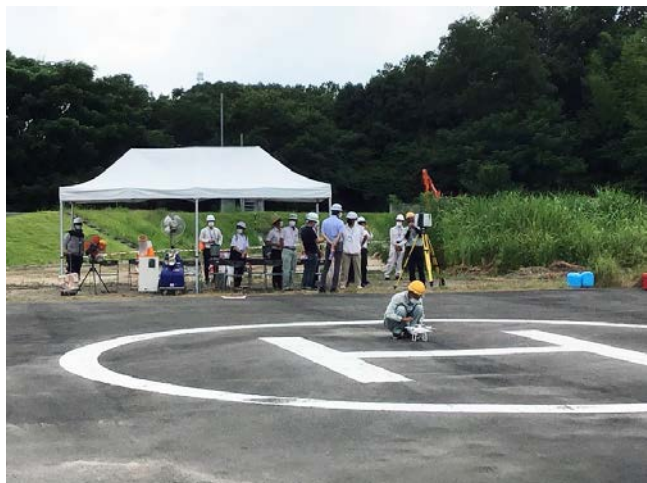
写真-4 ドローン（UAV）による起工測量実演風景
