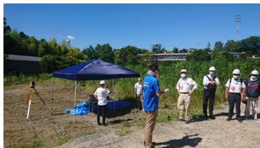
写真-6 TC(TS)を使用した出来形検査
