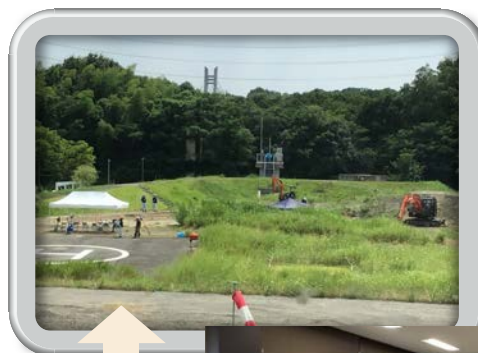
オペルームから見た 無人化施工ヤード
