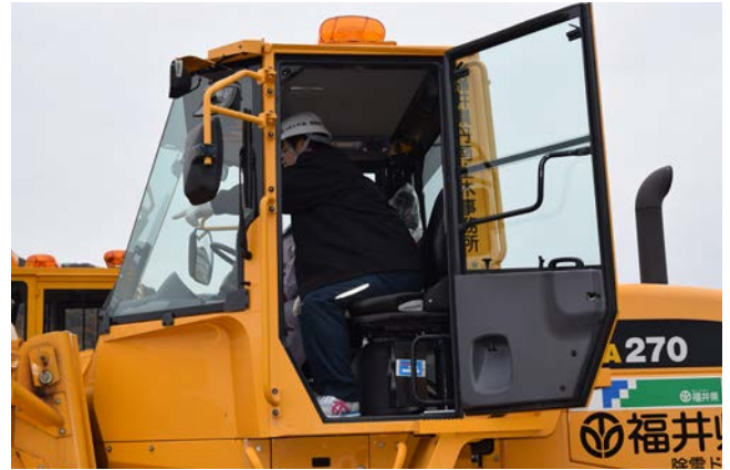
写真-4 実技施工訓練
