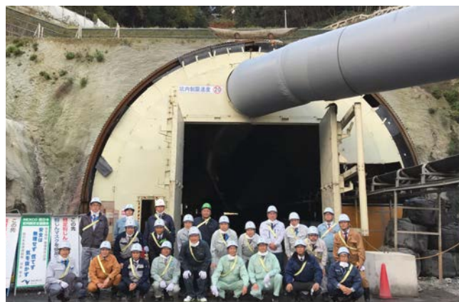
写真-2 鳥松山トンネル工事現場
