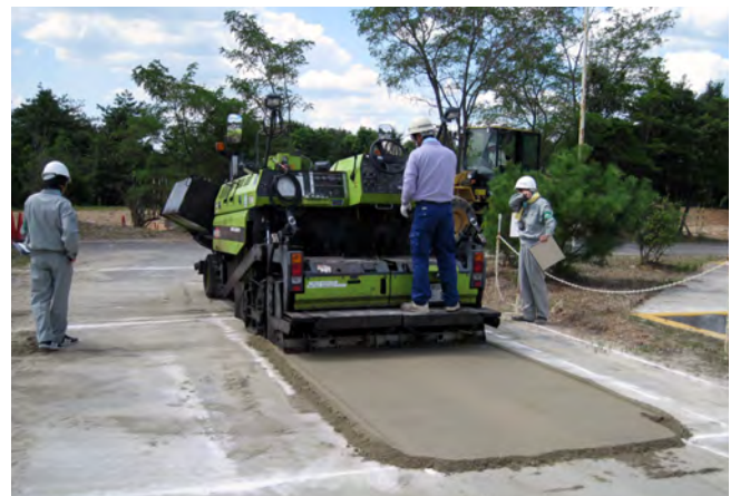
第5種(アスファルト・フィニッシャー)の受検風景
